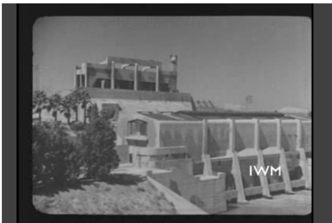
Figura 2: suntuosa represa de propriedade sionista
