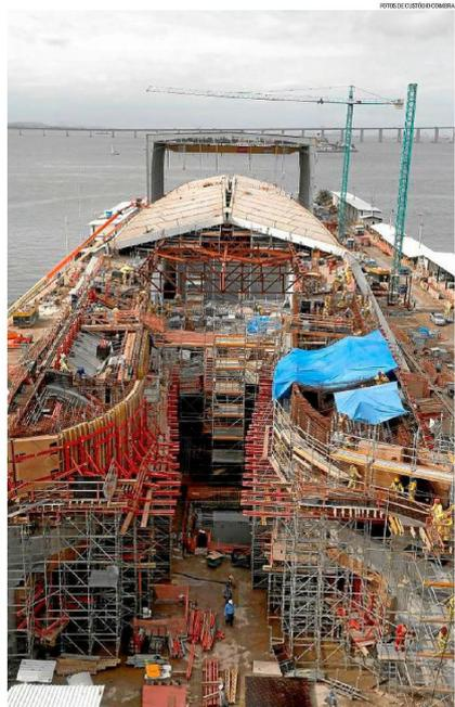
Do alto, Placas de aço da cobertura que terá 3.800 toneladas se destacam na construção, ao longo do Pier Mauá
