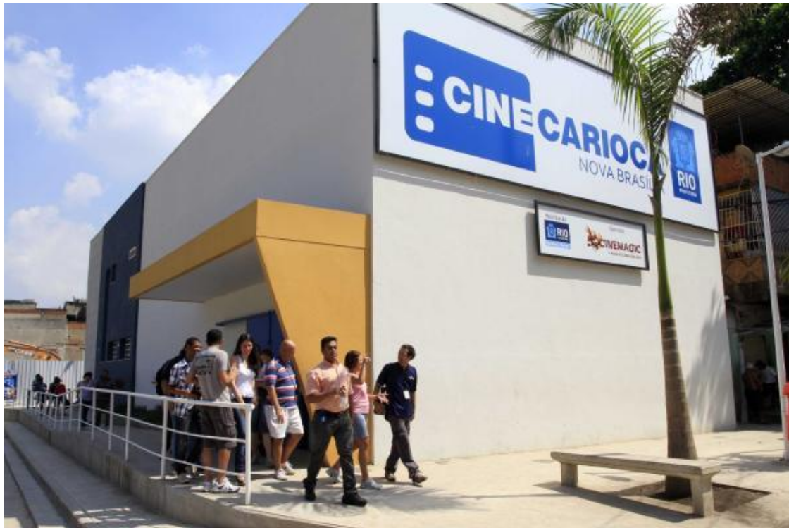
Figura 10. Fachada do Cine Carioca Nova Brasília. Fonte: http://rio.rj.gov.br
